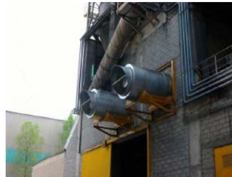
Silenciadores e portas acústicas para uma indústria de cimento.
