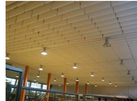
Absorres especiais, laváveis e sem fibras, para ambientes com elevados requisitos de higiene, exemplo de aplicação numa fábrica de cerveja.
